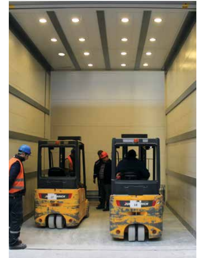
Hydraulic lift (rated load 10.000 kg) Hydraulikaufzug (Nutzlast 10.000Kg)
